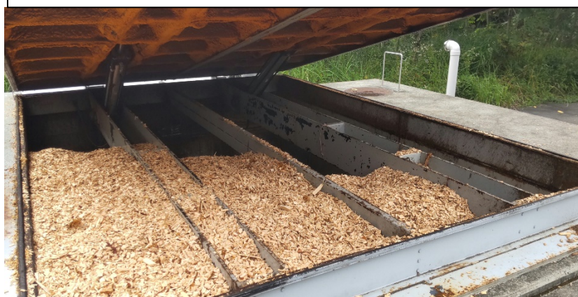
上写真のボイラーで使用する木質チップ
