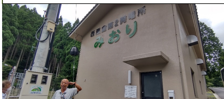
西粟倉村第2発電所 みおり
