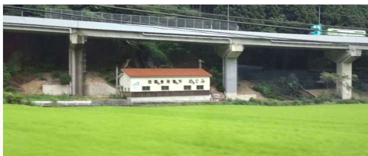
西粟倉村第1発電所 めぐみ
